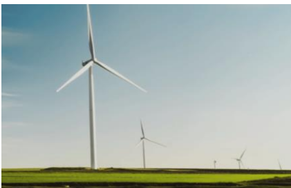
Betreiber von Biogas oder Windkraftanlagen
